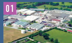
Howa Tramico SAS Brionne工場
