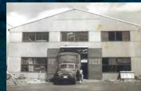
春日井工場新設(愛知県春日井市)
