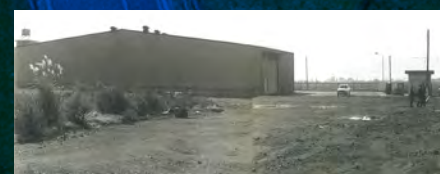
厚木工場新設(神奈川県厚木市)
